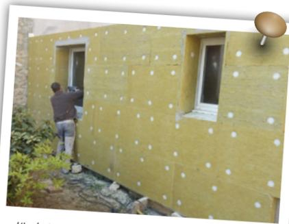
L'isolation par l'extérieur est une des clés pour limiter la déperdition de chaleur. Elle consiste à installer une enveloppe calorifuge autour de l'habitat qui sera ensuite recouvert d'un bardage (bois, enduit...)
